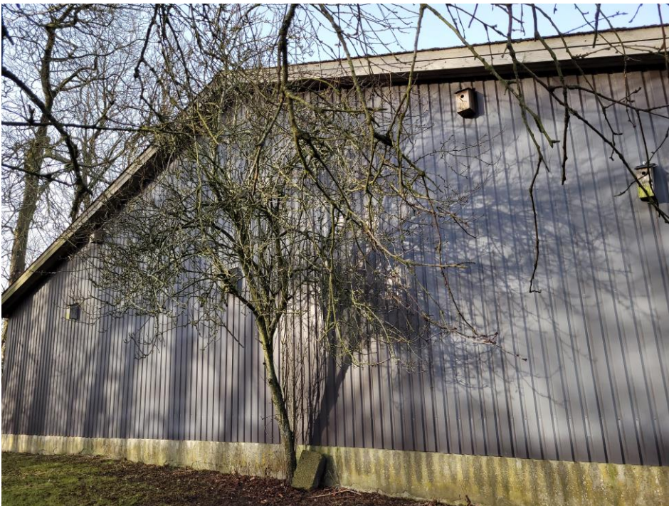
Figur 33: Fuglekasser på staldbygning
