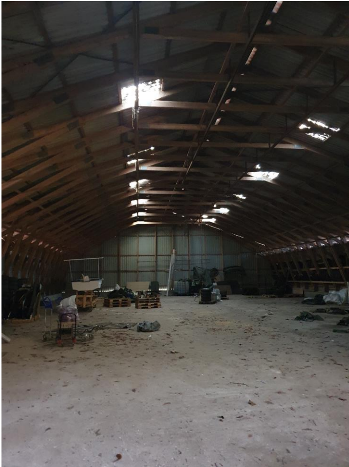
Figur 12: Stor lade af 1-lags metalplader.
