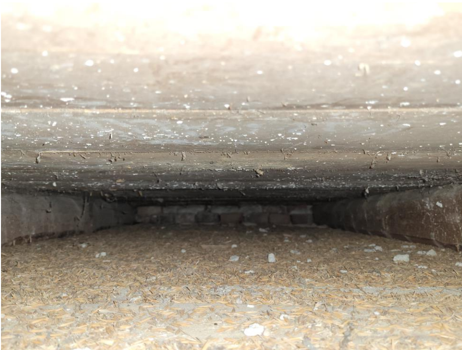
Figur 27 Hulrum under gulv på sydvendt loftrum, skaldele fra korn.
