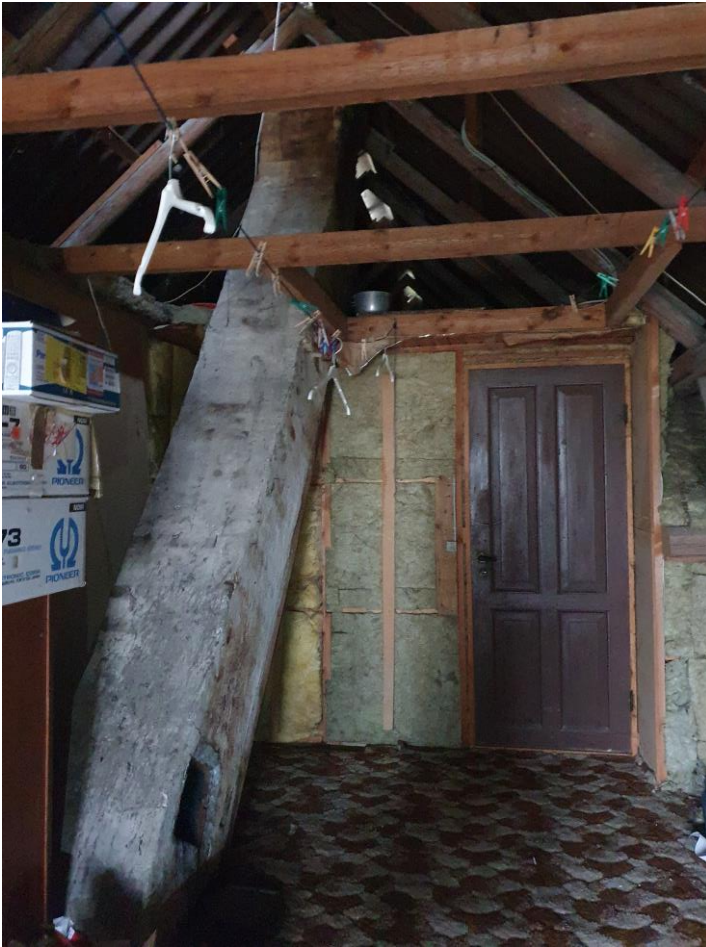
Figur 18 Vestvendt lofttrum, med aktiv skorsten og hulrum i isoleringen ind mod beboelige værelser
