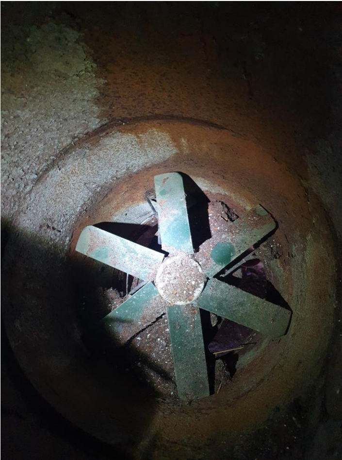
Figur 9 Inderside af metalskorsten/ventilationsrør
