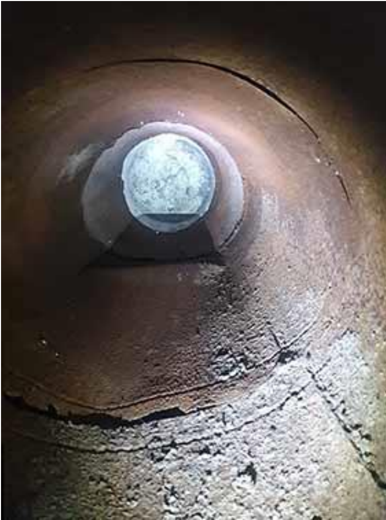
Figur 10: Inderside af metalskorsten/ventilationsrør
